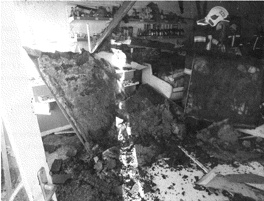
1. sz. kép. Decs, kereskedelmi létesítmény tűz
